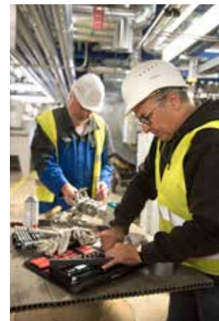
Hier wird ein Druckmessumformer im Maschinenhaus repariert
